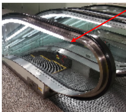
ハンドレール下部 照明用ランプソケット
