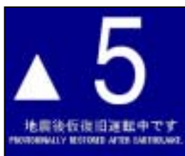
仮復旧運転時
