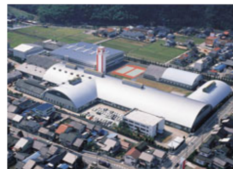
エスカレータ生産の拠点「日高製作所」稼働(1989年)
