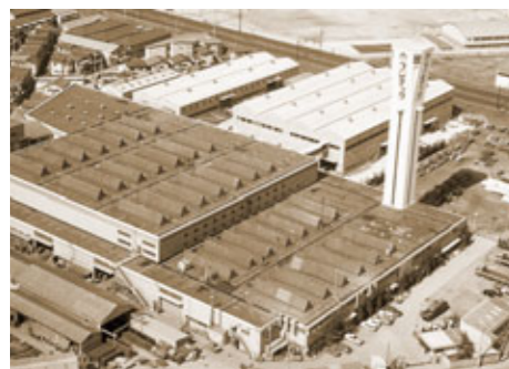
地上53mのエレベータ研究塔を有する「大阪製作所」(1965年)
