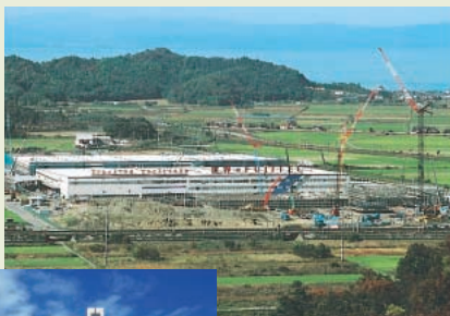
順調に工事が進む建設現場
