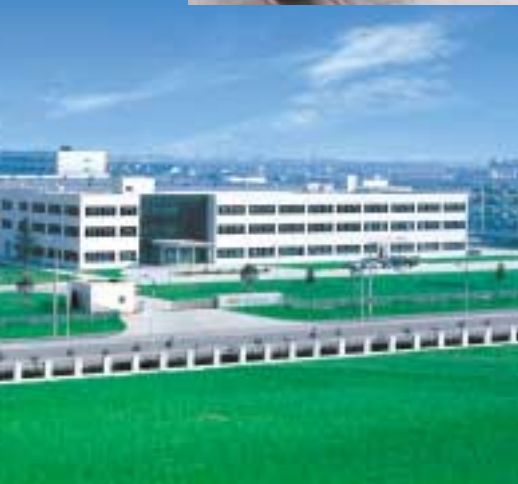
上海フジテック城に建つ「上海華昇フジテック」(右)と 「上海RDセンター」(左)
