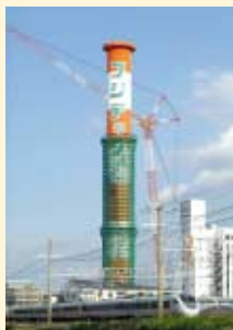
解体が進む エレベータ研究塔(茨木)
