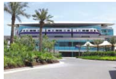
パーム・ジュメイラのモノレール駅舎
