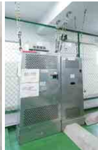
制御盤を耐震補強
