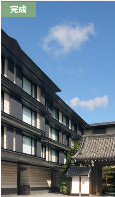
HOTEL THE MITSUI KYOTO (日本・京都) エレベータ計9台
