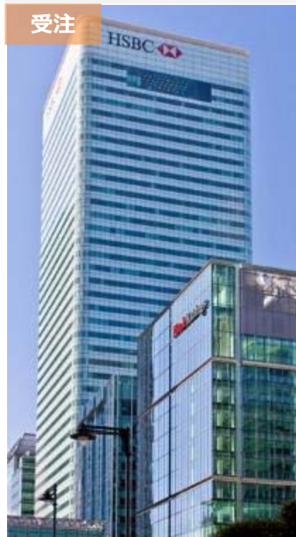
HSBC本社ビル (英国・ロンドン) エレベータ計15台
