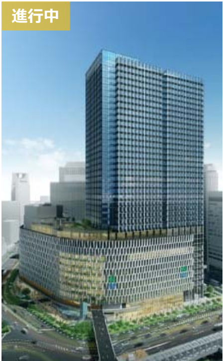
大阪梅田ツインタワーズ・サウス (日本・大阪) エレベータ・エスカレータ計30台
