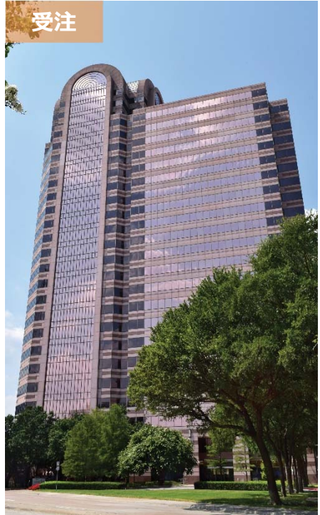
Galleria III (米国・テキサス州) エレベータ15台
