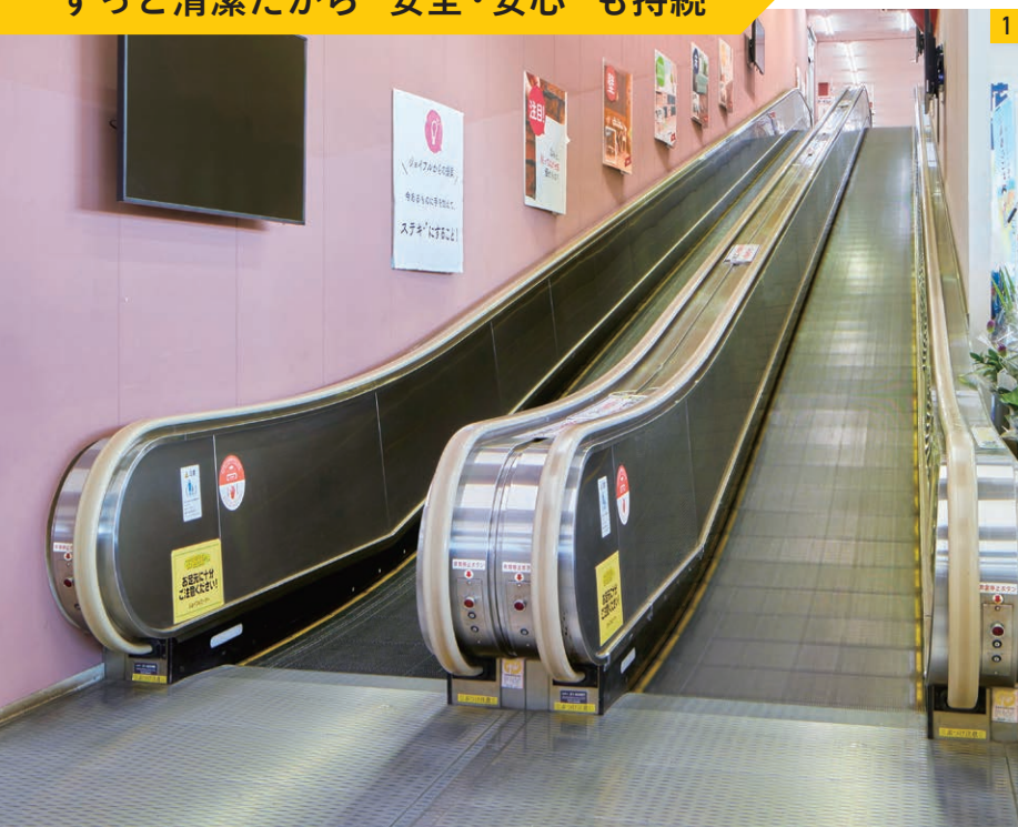
1 ジョイフルエーカー屯田店で稼働中のエバーフレッシュ設置済みオートウォーク 2 専用ラベルでUV除菌中であることをお知らせ 3 運転中は内部でハンドレールにUV照射
