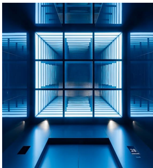
光を無限に映し出すミラー天井 遠隔操作によるグラデーション照明が可能
