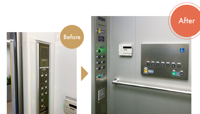
感染症対策も考慮して採用となった非接触ボタン「エアータップ」の操作盤を追加したかご内。「両手に荷物を持っても反応するので便利」などの声も上がっている。
