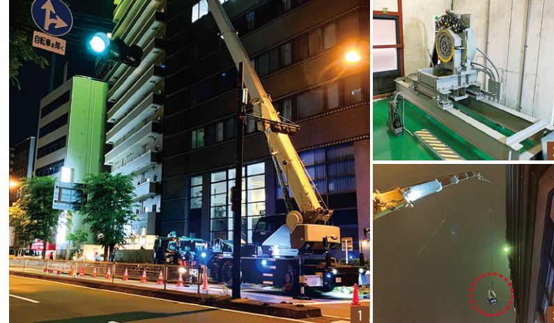
[1]機械室の巻上機は、長さ、重量の関係でクレーンでの荷揚げを実施。警備のために昭和設計のご担当者さまにも立ち会っていただいた。[2]駆動部である巻上機の重量は830kg。[3]わずかな揺れで建物にぶつからないよう慎重な作業を心がけた。
