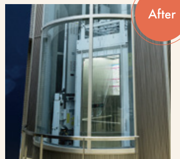
四角いかごをきれいに収め、既設の外壁にも合うように仕上げた
