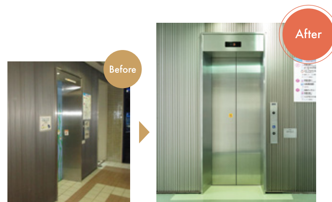
展望用エレベータの乗場、「かごの新旧出し入れ後も入り口周りを既設と変わらない意匠にしたい」とのご要望に応え、酷似した素材を調達した。
