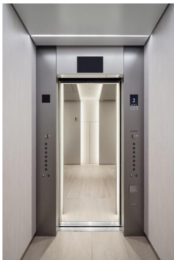
オフィスフロア行きエレベータ かご内
